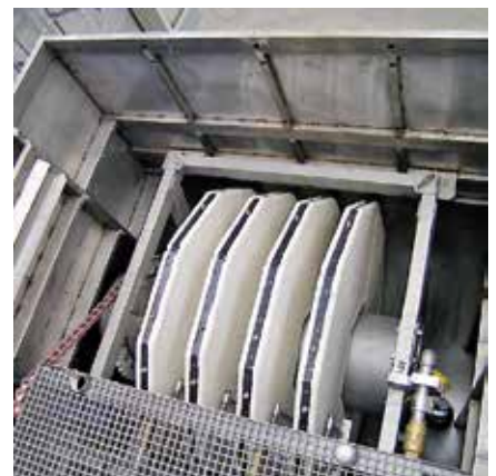
Schema tipico filtro MITA a dischi
