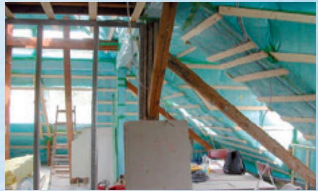
La misurazione BlowerDoor per l'assicurazione qualità in fase di costruzione
